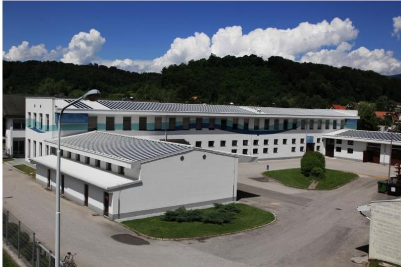
Slika 4: Sončna elektrarna na upravnem objektu in na sosednjih objektih v sklopu Termoelektrarne Brestanica.
